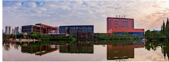
■ Institut de Chimie de Chongqing University - Source : CQU
